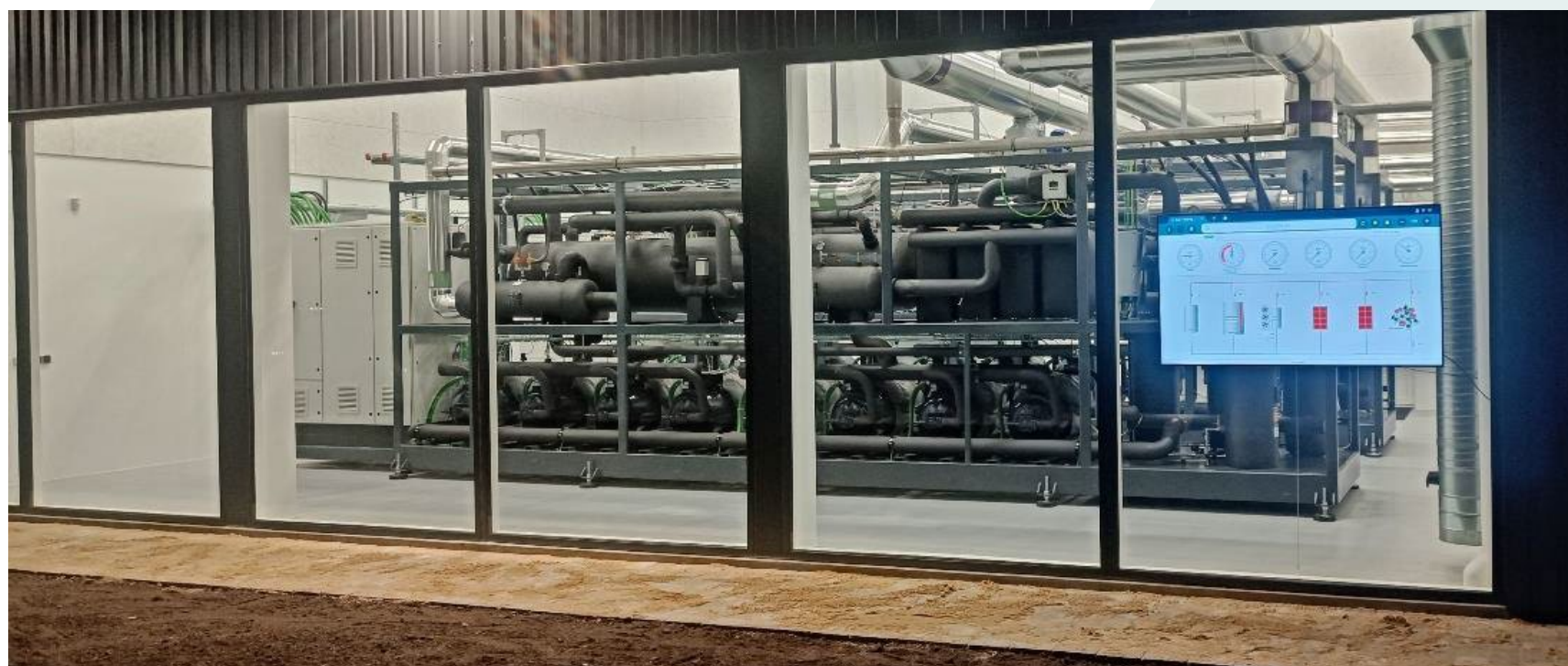
Fenagy CO2 varmpumpeanlæg H1800
