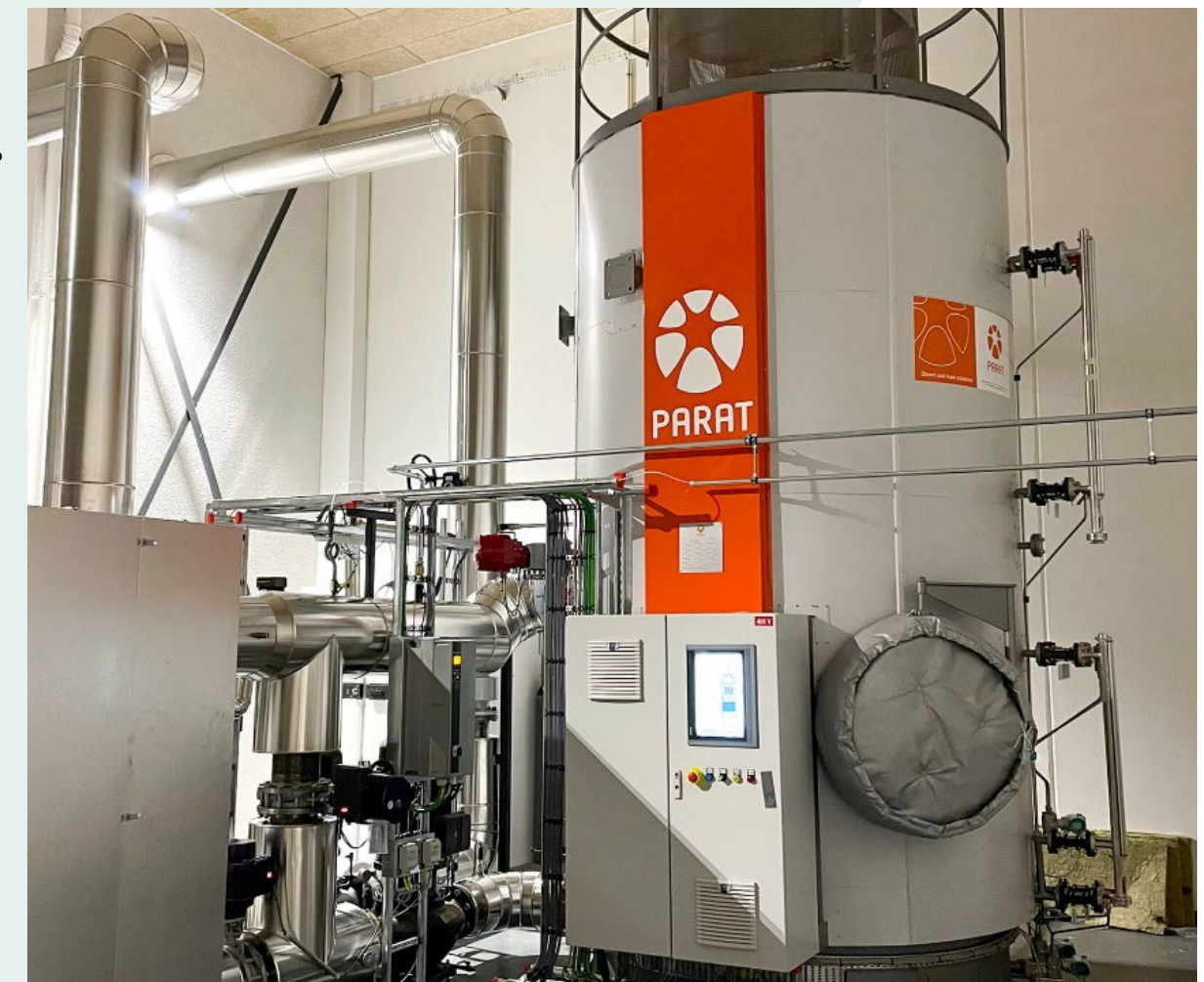
Eksempel fra Brande Fjernvarme (15 MW elkedel)
