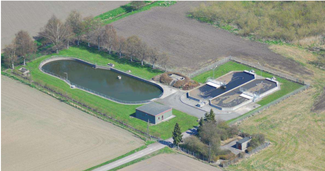
Figur 9 Luftfoto af Karise Renseanlæg – før reovering og udvidelse.
