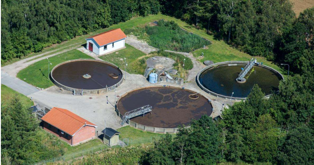
Figur 25 Luftfoto af Dalby Renseanlæg.
